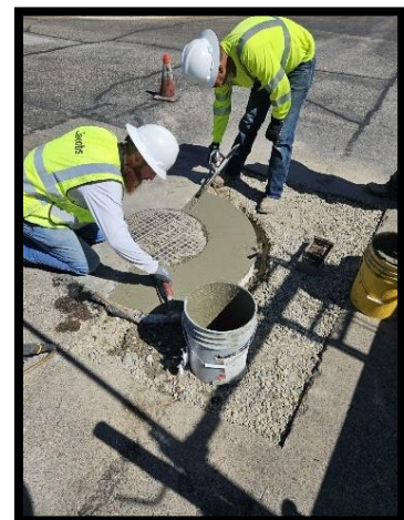
Manhole Repair.
